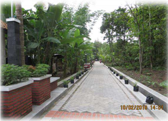
Drainase dan jalan yang baik
